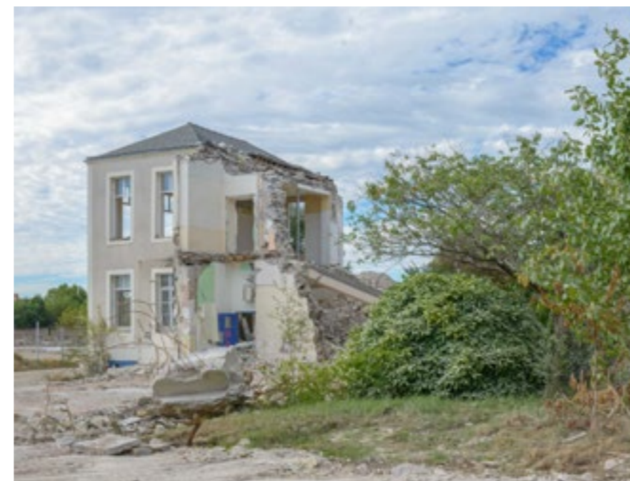
Chantier de démolition, caserne Mellinet à Nantes.
